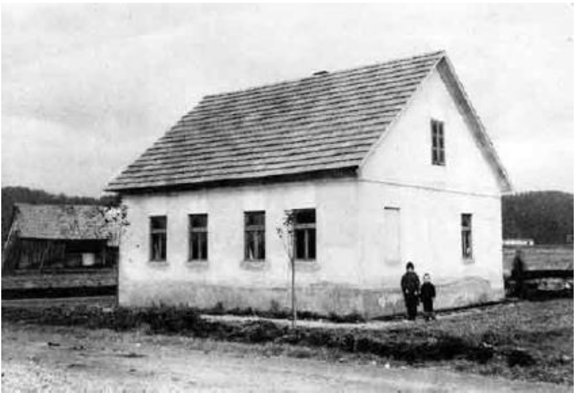
Hiša št. 33 na Ižanski cesti.
