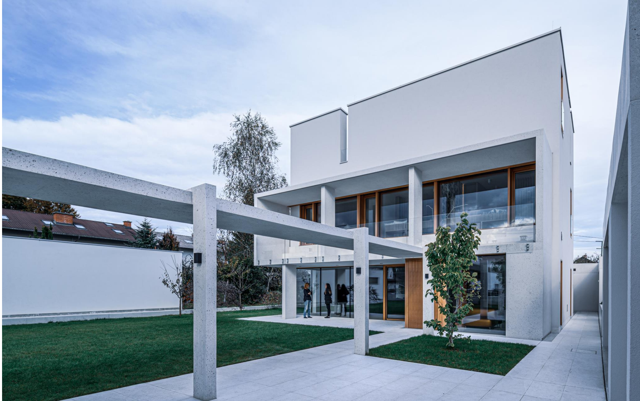
Stanovanjska hiša v Rožni Dolini, M. Blenkuš, K. Cimperman, A. Peček, 2020
