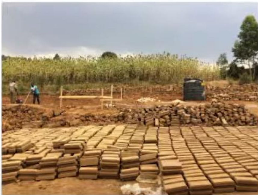
// Sušenje zidakov iz prsti na mestu gradnje // Drying of earth compressed bricks on th site
