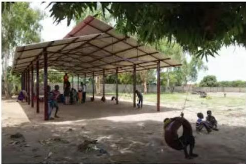
// Nadstrešnica z otroškim igriščem, prva grajena struktura Izobraževalno - kariernega središča // Canopy with playground, first structure of the Learning and Career Centre
