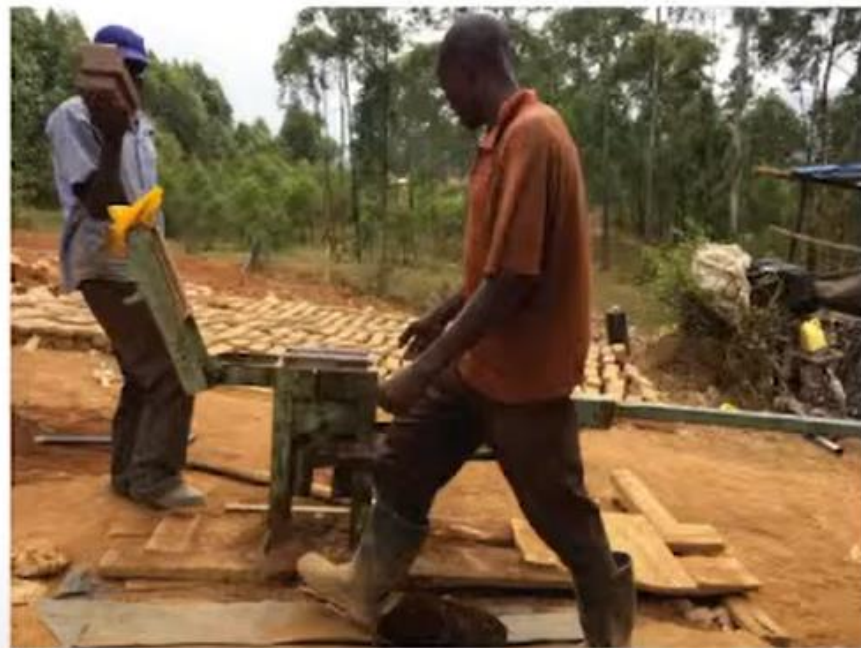
// Izdelava zidakov iz prsti z ročno prešo na mestu gradnje (mešanica prsti, cementa in vode) // Making of the earth bricks with a manual press (mixture of soil, cement and water)
