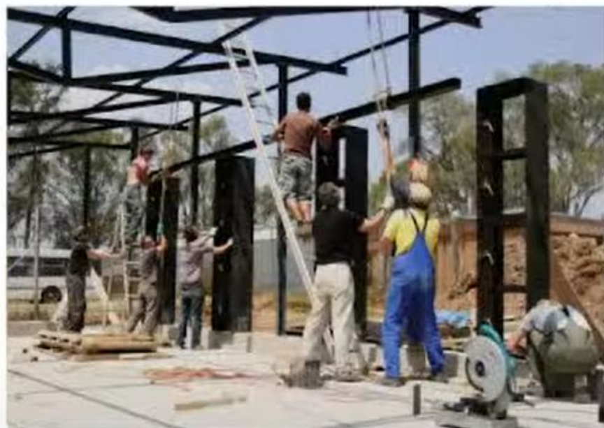
// Postavljanje jeklene konstrukcije // Putting up of steel structure
