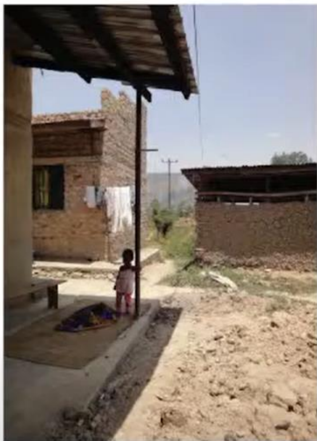
// Običajna gradnja hiš: iz žganih opek ali iz blata // Usual construction of houses: burnt bricks or adobe
