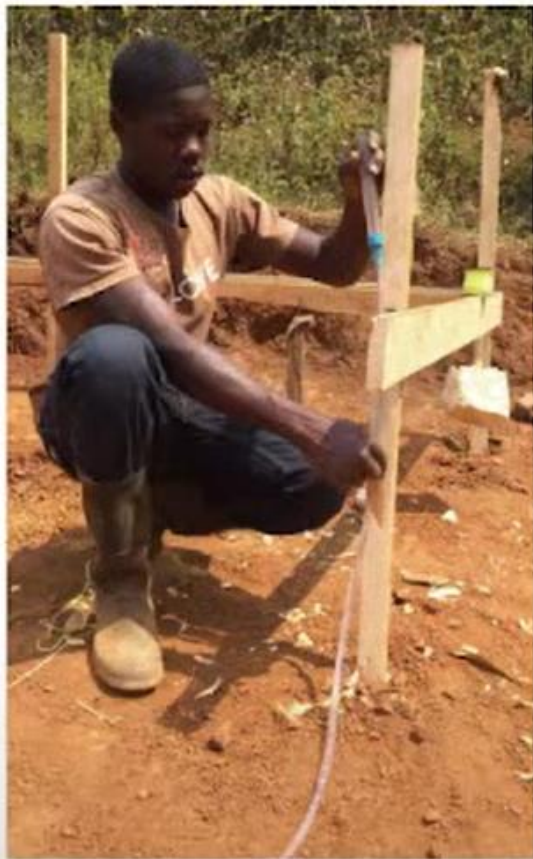
// Gradnja s preprostimi orodji: cevna veža // Building with simple tools: water level
