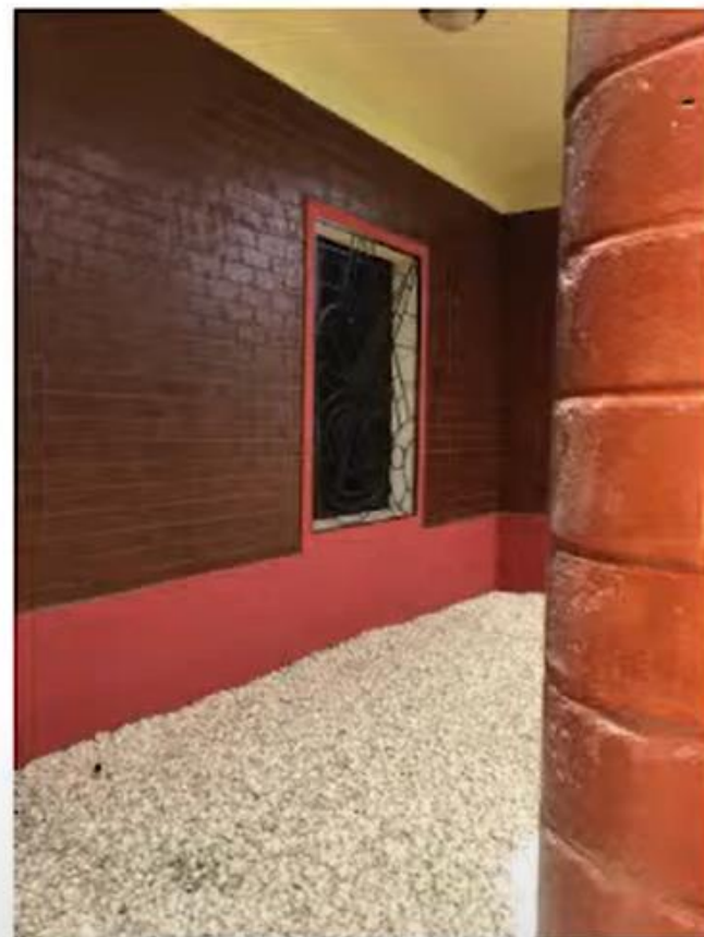
// Stene iz zidakov iz prsti in tlak iz atlantskih školjk // Brickwork from earth compressed bricks, floor made of Atlantic shells
