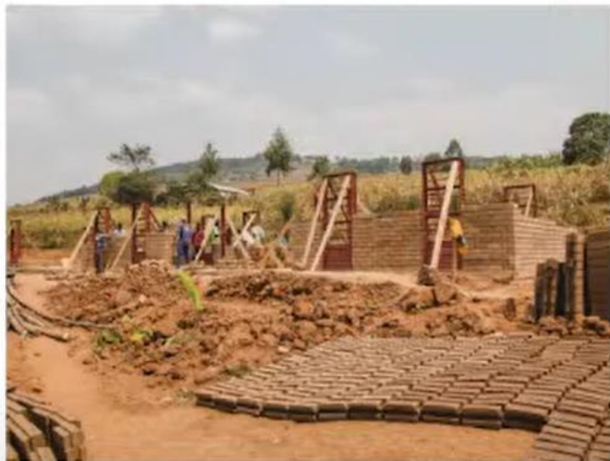
// Stene iz zdalakov iz prsti med jeklenimi okenski okvirji // Walls between steel window frames, made of earth compressed bricks
