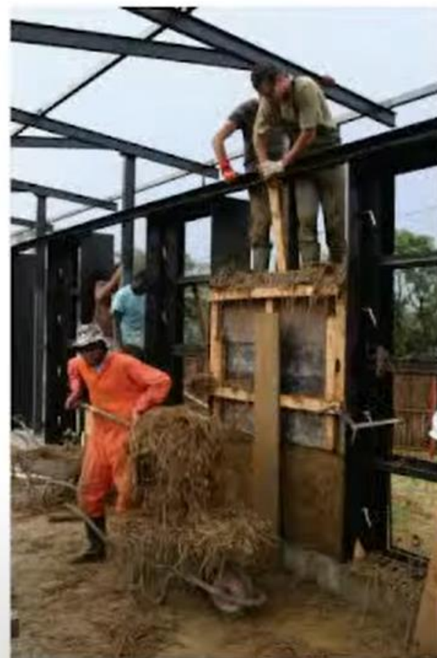
// Butenje sten iz slame in glin // Ramming of straw and clay walls
