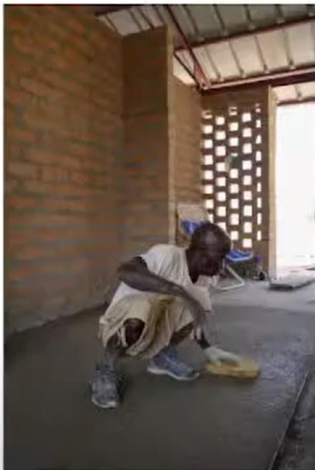
// Zidar, ki izdeluje zaključni tlak - lokalni "terazo" z morskimi školjkami iz Atlantika // Mason making local "terazzo" with sea shells from the Atlantic
