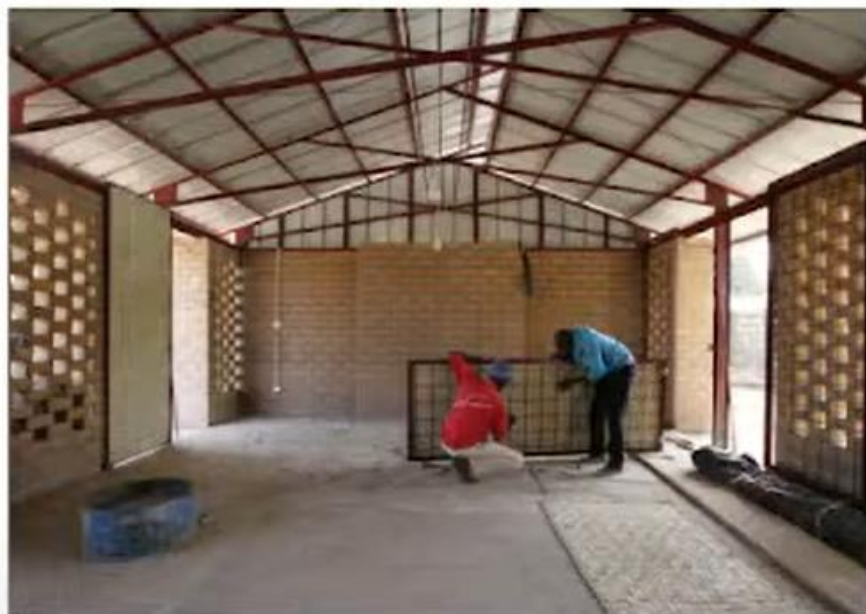
// Pritrditev mreže iz bambusovih trakov na kovinske okvirne drsnih panelov // Fixing of woven mesh from bamboo stripes onto metal frames of sliding panels
