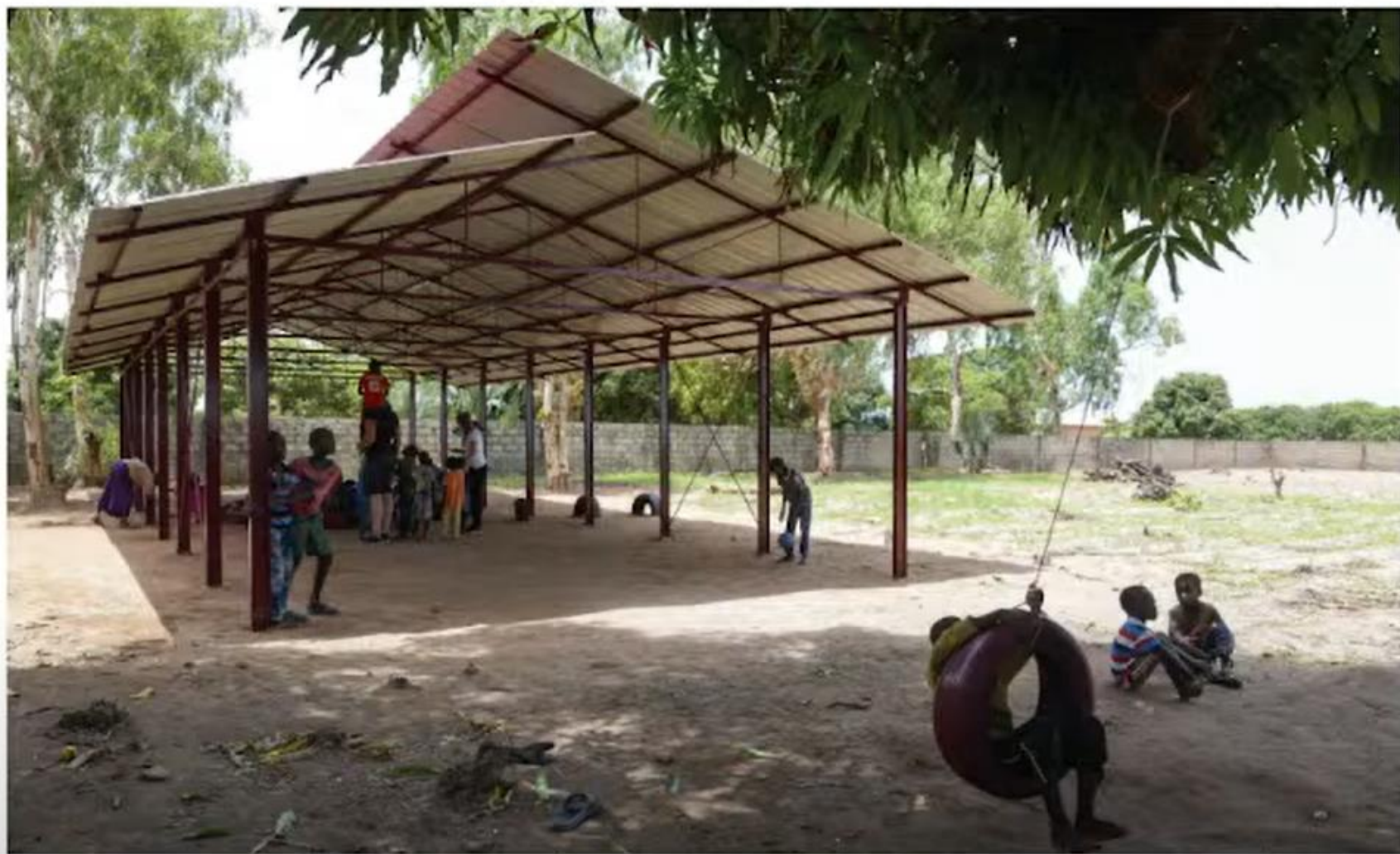
// Nadstrešnica z otroškim igriščem, prva grajena struktura Izobraževalno - kariernega središča // Canopy with playground, first structure of the Learning and Career Centre
