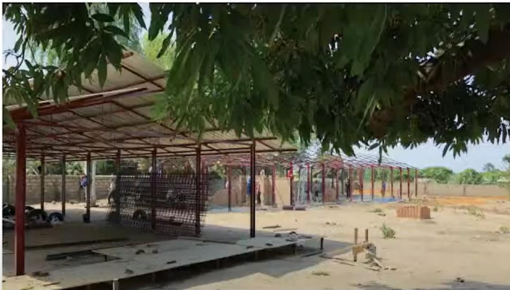
|| Zidaniye sən Məliə tələs pəstəni zidani || Bricklaying of the Nursery School with earth bricks
