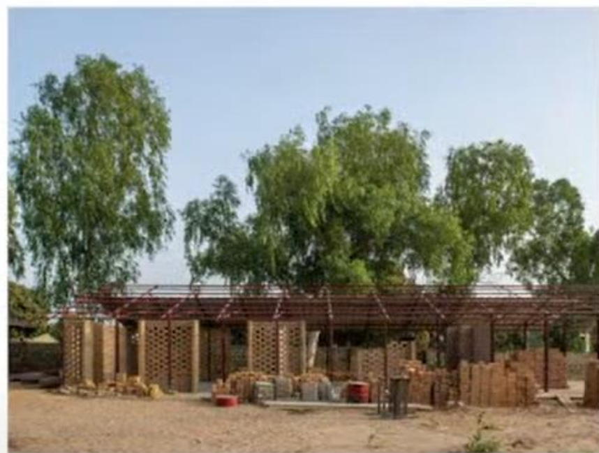
// Zidaki iz prsti in kovinska konstrukcija // Earth compressed bricks and steel structure
