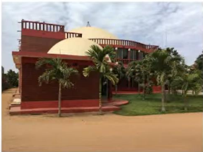
// Kulturni center v Senegambiji, grajen iz zidakov iz prsti (stene in kupole) // Cultural Centre in Senegambia, built with earth compressed bricks (walls and domes)
