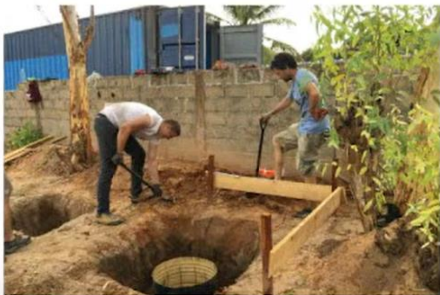
// Temelj: stari pločevinaš sodi - opasž za temelje, položeni na podložni beton // Foundations: old drums, casts for foundations, fixed onto the base concrete
