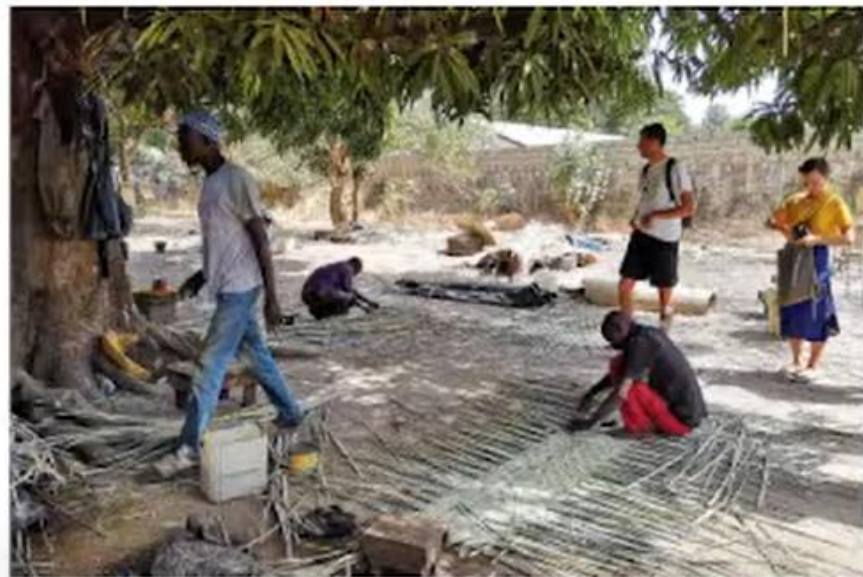
// Lokalni mojstri tkejo mrežo iz bambusovih trakov za drsne panele // Local workers make mesh from bamboo stripes for sliding panels
