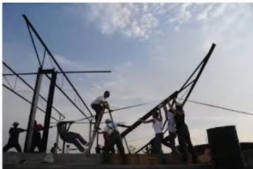
// Postavljanje jeknenih okvirjev širine 11 metrov // Erecting of 11 meters wide steel frames
