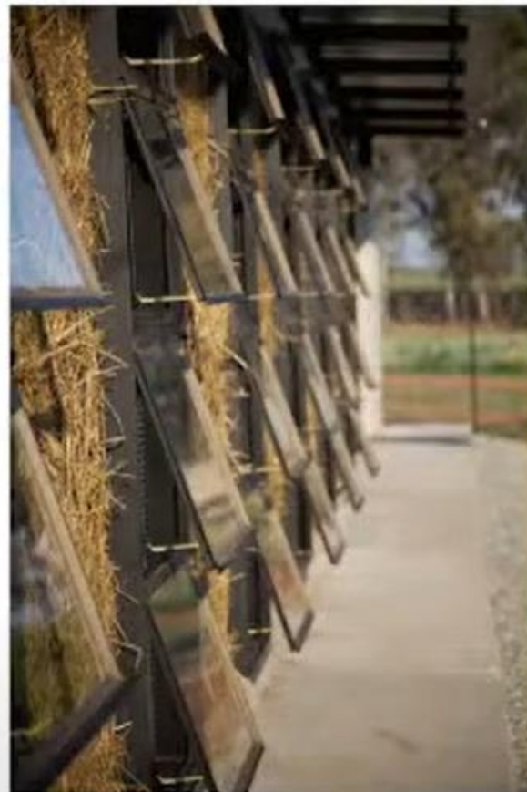
// Dvojna zasteklitev severne fasade služi pasivnemu ogrevanju notranjosti v zimskem času // Double glazing of northern facade for passive heating of interior in winter
