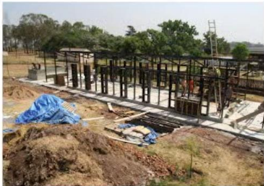
// Jeklena konstrukcija Učionice in knjižnice // Steel structure of Classroom and Library
