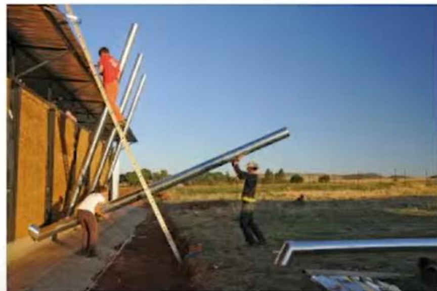
// Južna fasada - postavljanje zračnikov za izveik mrzlega zraka // Southern facade - fixing of the vents for suction of cold air
