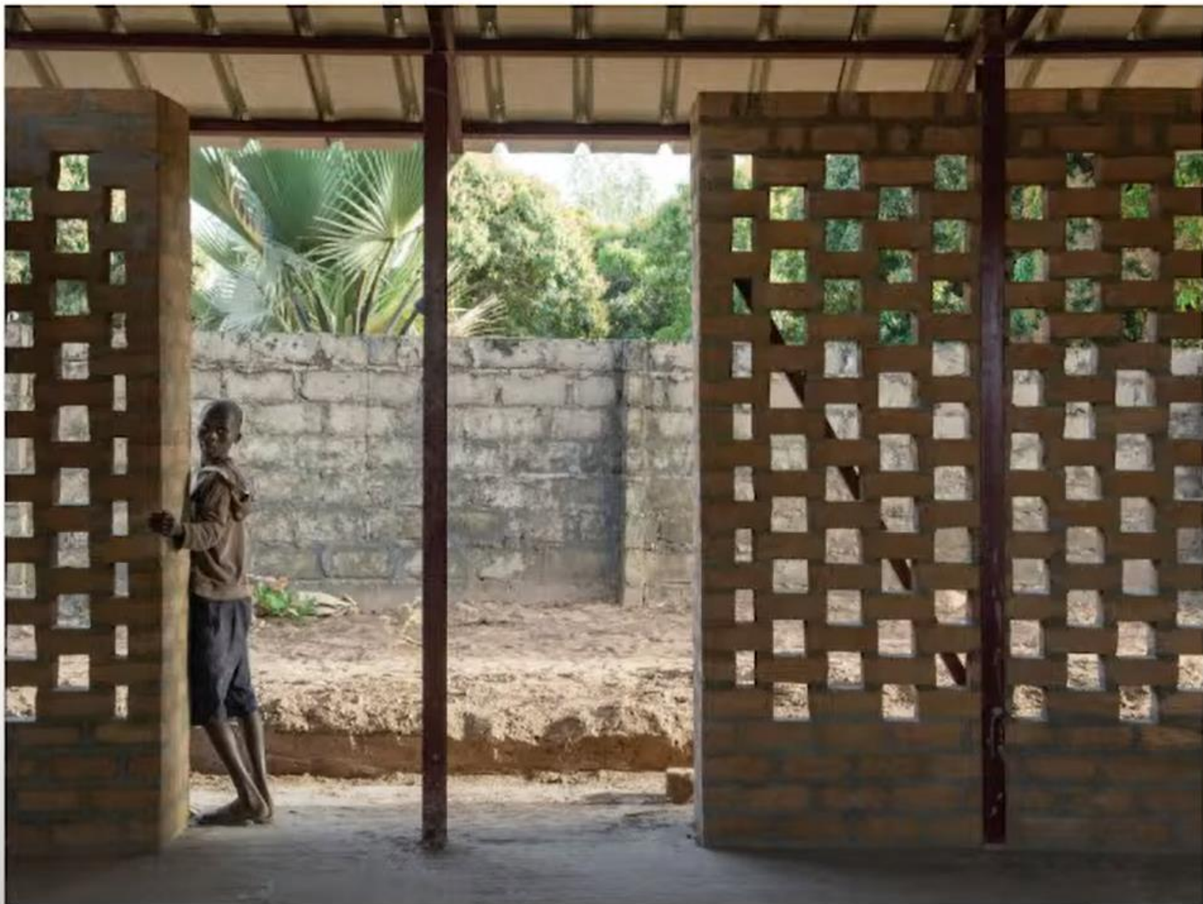
// Zidaki iz prsti: čipkaste opečne stene učilnic // Earth compressed bricks, "faced" brick walls of the classrooms
