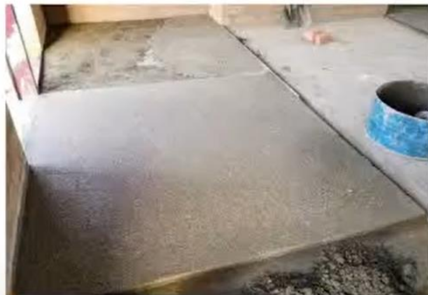
// Zaključni tlak: lokalni "terazo" z morskimi školjkami iz Atlantika (2.0cm) // Floor: local "terazzo" with sea shells from the Atlantic (2.0 cm)
