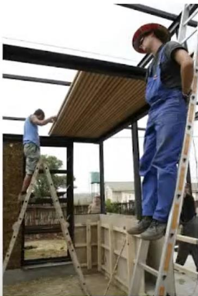
// Namešćanje stropnih panelov iz kartonskih tulcev // Fixing of cardboard tubes panels for ceiling
