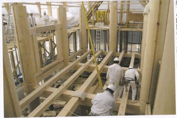
壁板が柱の小穴に落とし込まれる。
