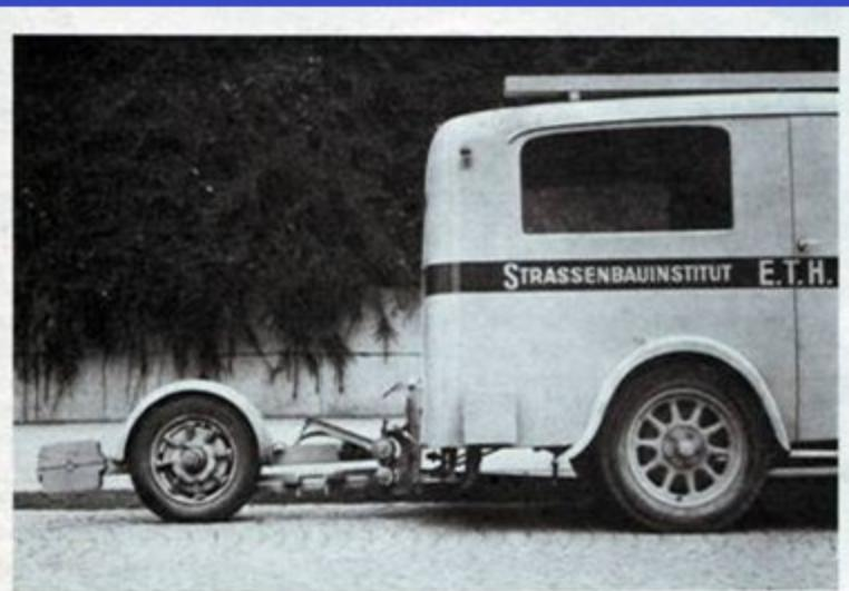
Fig. 1. Apparatur zur Messung der Bremsmomente nach der Methode Schindler.
