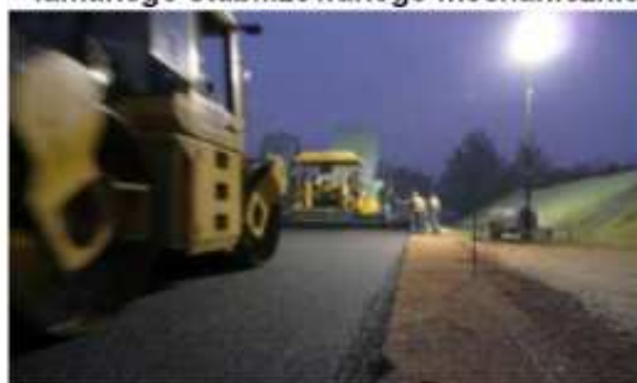
Fot. 3 Prace przy wykonaniu oraz widok warstwy ścieralnej SMA 8 DE80C
