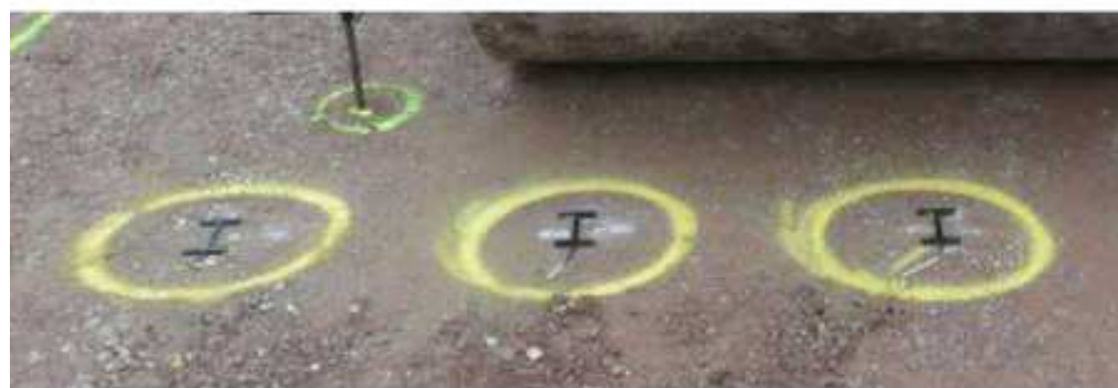
Fot. 2 Czujniki odkształceń (ASG) na warstwie podbudowy z kruszywa łamanego stabilizowanego mechanicznie
