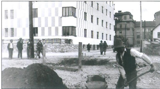
138. Gradbena dela za vilo Pirkmajer so se začela
