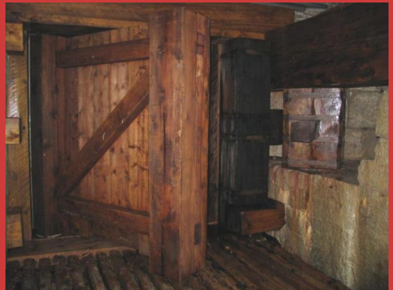
Mehanizem za odpiranje klavžnih vrat.
